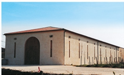
Construction d'un chai en brique monomur de 1200 m 2 à Catusseau.
