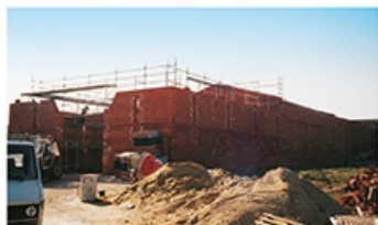
Construction d'un chai en brique monomur de 1200 m 2 à Catusseau.
